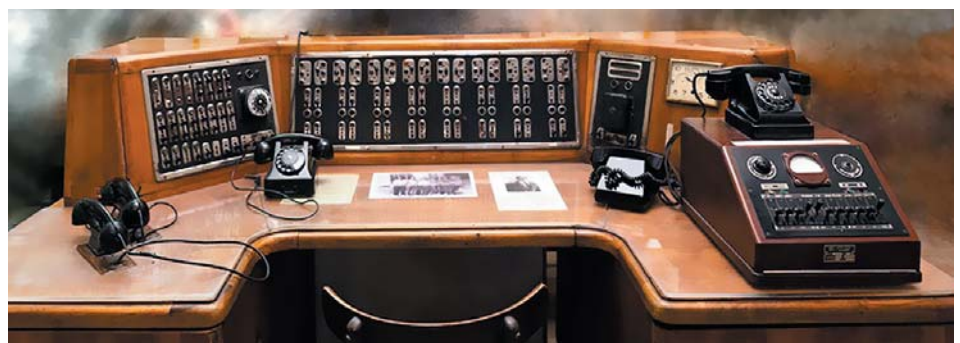
Рис. 5. Пульт УТУ-60 телемеханической системы управления городским освещением из музея «Огни Москвы»
