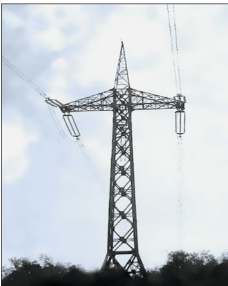
Рис. 7. Опора HVDC ЛЭП Донбасс–Волгоград
